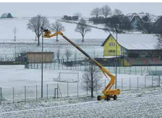
Erneuerung der Flutlichtanlage
