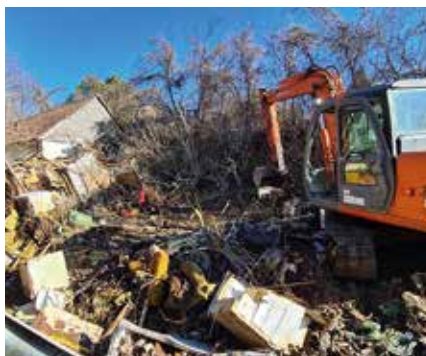
VORHER – Müllberge soweit das Auge reicht / NACHHER – 180 Arbeitsstunden / 6 Tage Baggerarbeiten, später (130 m³ Schutt und 150 m³ Sperrmüll/Eisen/Holz wurden entsorgt)
