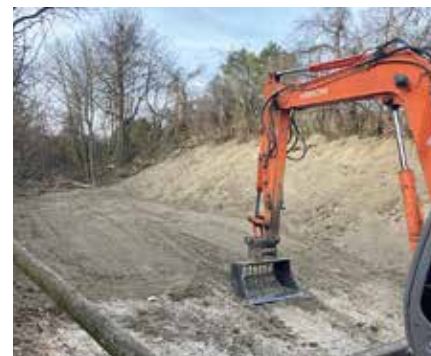
VORHER – Müllberge soweit das Auge reicht / NACHHER – 180 Arbeitsstunden / 6 Tage Baggerarbeiten, später (130 m³ Schutt und 150 m³ Sperrmüll/Eisen/Holz wurden entsorgt)
